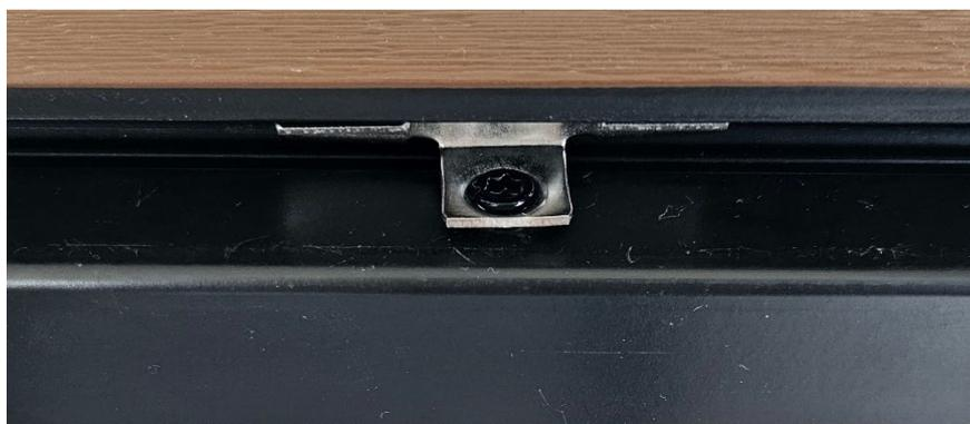
Montage eines Brettes mit Clip an der Unterkonstruktion
