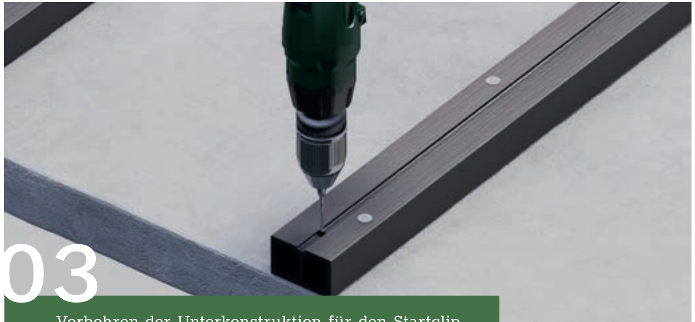
Vorbohren der Unterkonstruktion für den Startclip
